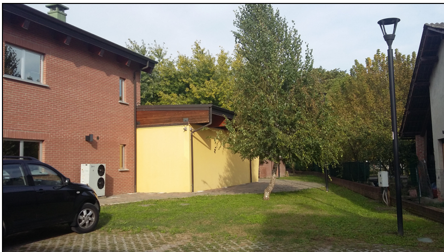
Figura 40. Prospetto sud: l'ambulatorio (parte con mattoni a vista) e la sala espositiva
