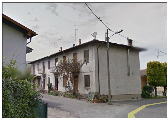
Figura 31. Edifici nella posizione 5, lato nord
