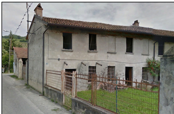
Figura 28. Edifici nella posizione 3
