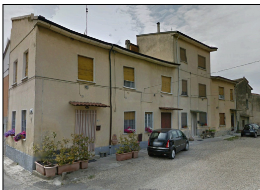
Figura 26. Edifici nella posizione 1
