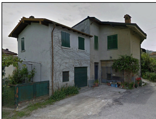
Figura 30. Edifici nella posizione 5, lato sud
