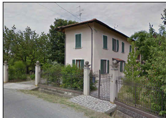
Figura 29. Edifici nella posizione 4
