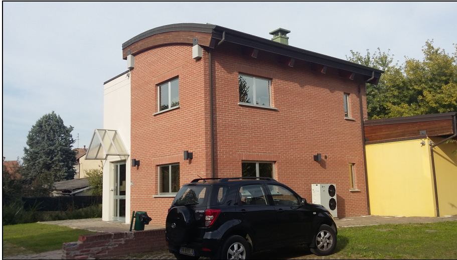
Figura 14. Facciata sud-ovest dell'edificio esistente: l'ambulatorio medico di due piani
