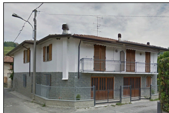
Figura 27. Edifici nella posizione 2
