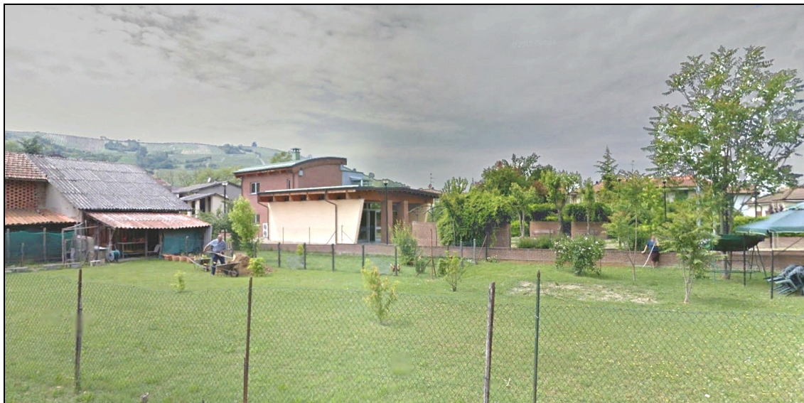
Figura 32. Fotografia dello stato di fatto
